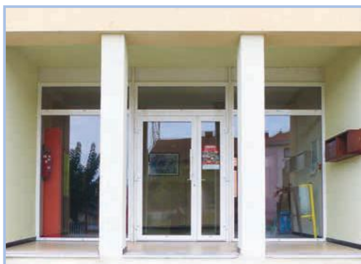
Nouvelles menuiseries à l'entrée de l'école primaire
