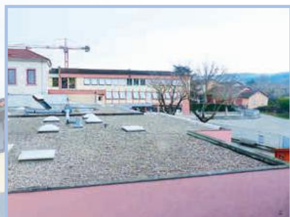
Rénovation de la toiture terrasse de l'école maternelle
