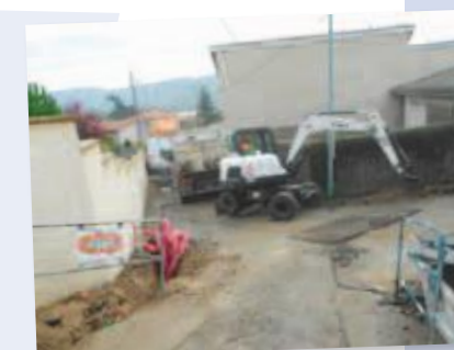
Enfin, le dernier chantier de l'année porte sur le renouvellement de la canalisation de distribution d'eau potable, la reprise des branchements au plomb et l'enfouissement des réseaux (EDF et Telecom) Rue et Impasse de la Viallière. A l'heure où nous vous informons, ces travaux se terminent, malgré la difficulté due à l'étroitesse de ces voies. Le chantier s'est déroulé dans de très bonnes conditions. Remerciements aux riverains qui ont su être patients et conciliants. La réfection de la voirie est prévue pour la deuxième quinzaine de janvier 2013. Nul doute qu'après, les riverains retrouveront leur quiétude.
