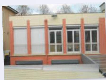
Remplacement des volets et fenêtres dans une classe à l'école primaire.
