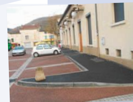
Aménagements sécuritaires de la place des Anciens Combattants améliorant la sortie de la salle des fêtes et sécurisant le sens unique de la Rue du 19 mars 1962.
