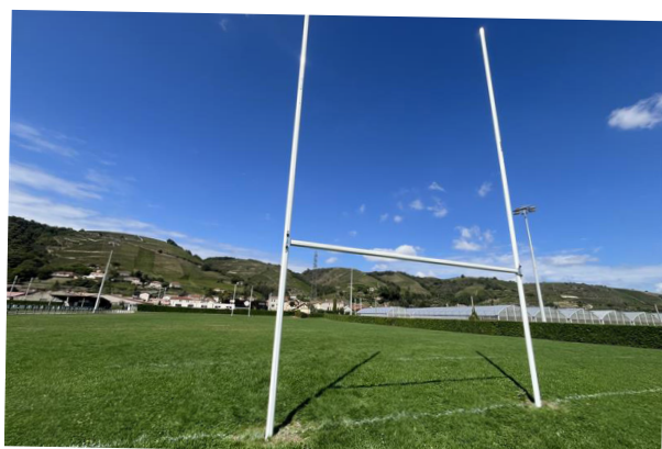
Stade de Rugby Remplacement des poteaux
