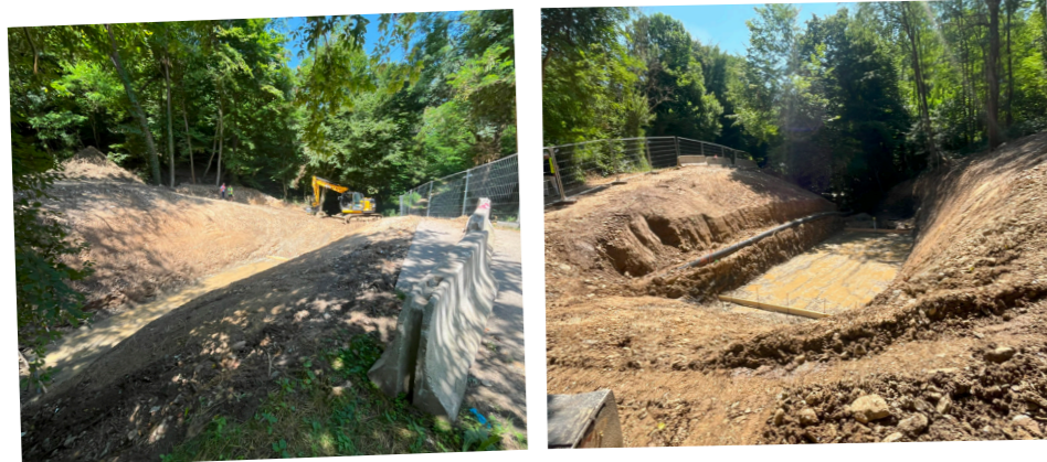
Pont de Charffage En cours de reconstruction
