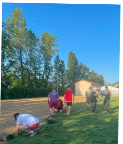
Stade de Rugby Enrobé et pose de gazon
