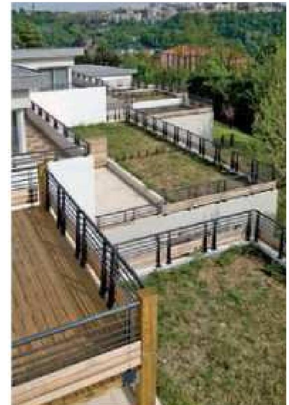
Toiture terrasse végétalisée et accessible, pour une meilleure gestion des eaux pluviales et de la thermique des bâtiments.
