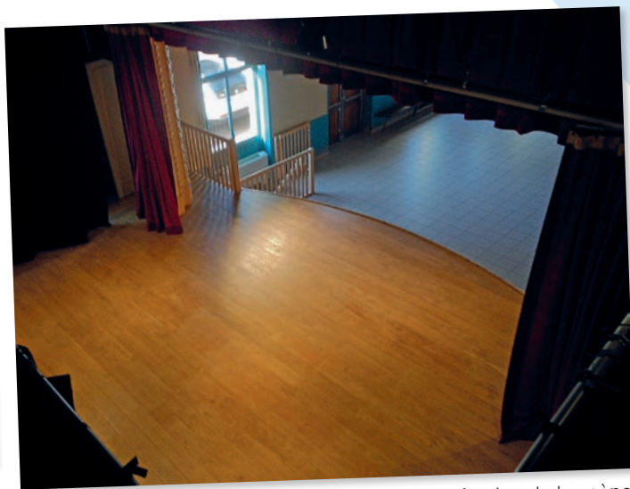
Réfection de la scène et isolation des combles de la Salle des Fêtes.
