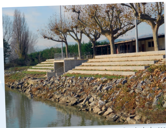
Création de gradins au Bassin de Joutes.
