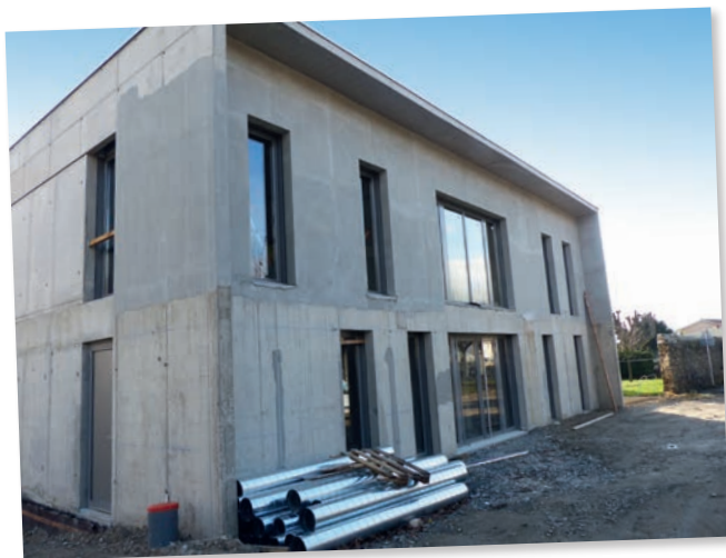
Maison médicale : la santé près de chez vous. Le chantier a démarré en avril 2014. Livraison prévue mars 2015.
