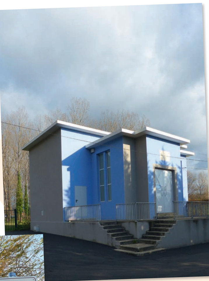
Ravalement de façade de la station de pompage à la Traille.
