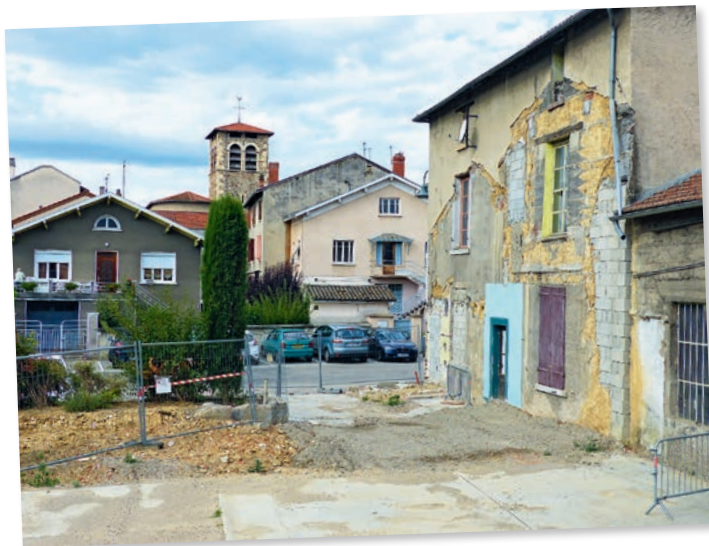
Mise en sécurité de l'Auberge du Chai : démolition de la partie qui menaçait de s'écrouler.
