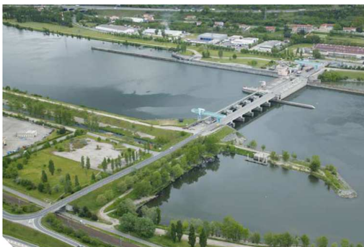
Aménagement de Vaugris (© Wikhydro)
