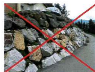
Exemple d'enrochements de type cyclopéen
