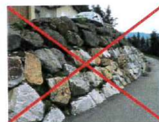
Exemple d'enrochements de type cyclopéen
