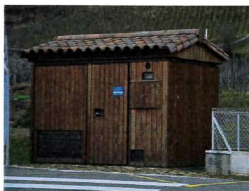
Exemple de traitement d'un transformateur électrique à privilégier
