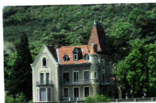
Exemple de toiture «atypique»
