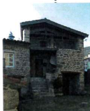
Exemple de débord de toiture
