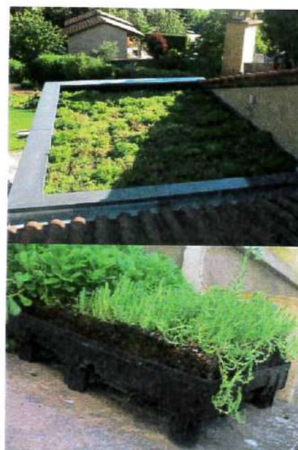
Exemple de toiture-terrasse végétalisée et bacs pré-cultivés
