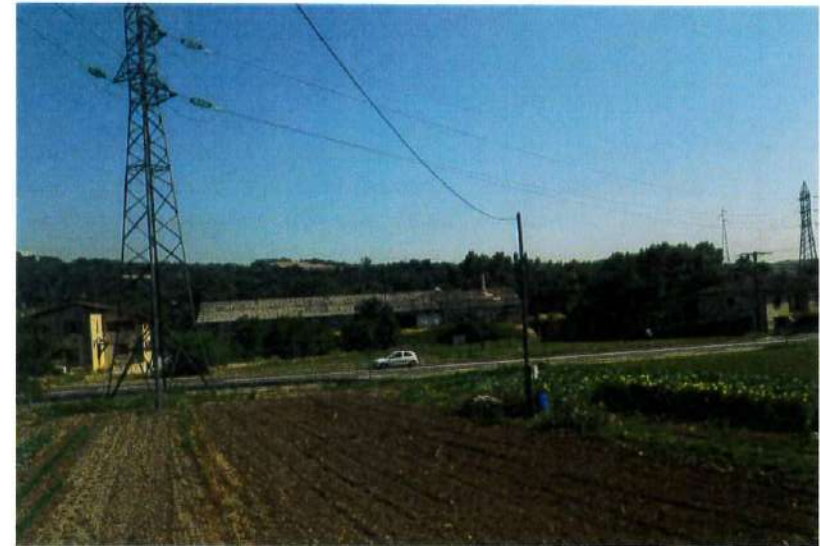
Depuis ch. de Montlys: un potager sous la ligne haute tension
