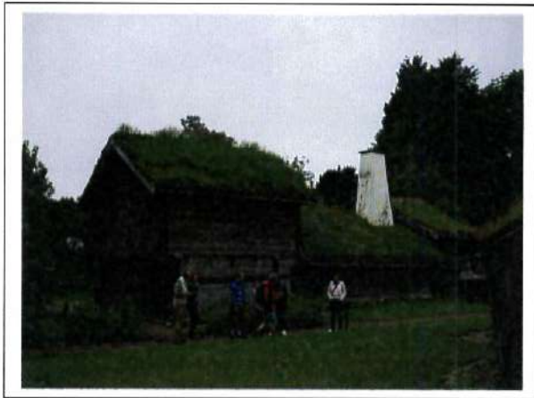
Toiture végétalisée et architecture « traditionnelle »
