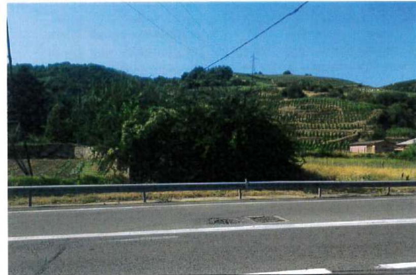
Le Cognet - Un ruisseau busé sous la RD 386
